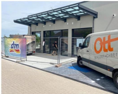
Das Gebäude steht, der Innenausbau ist in vollem Gange: Gleich neben seiner Flehinger Aldi-Filiale hat der Discounter ein Gebäude errichtet, in das ein dm-Drogeriemarkt als Mieter einziehen wird.
